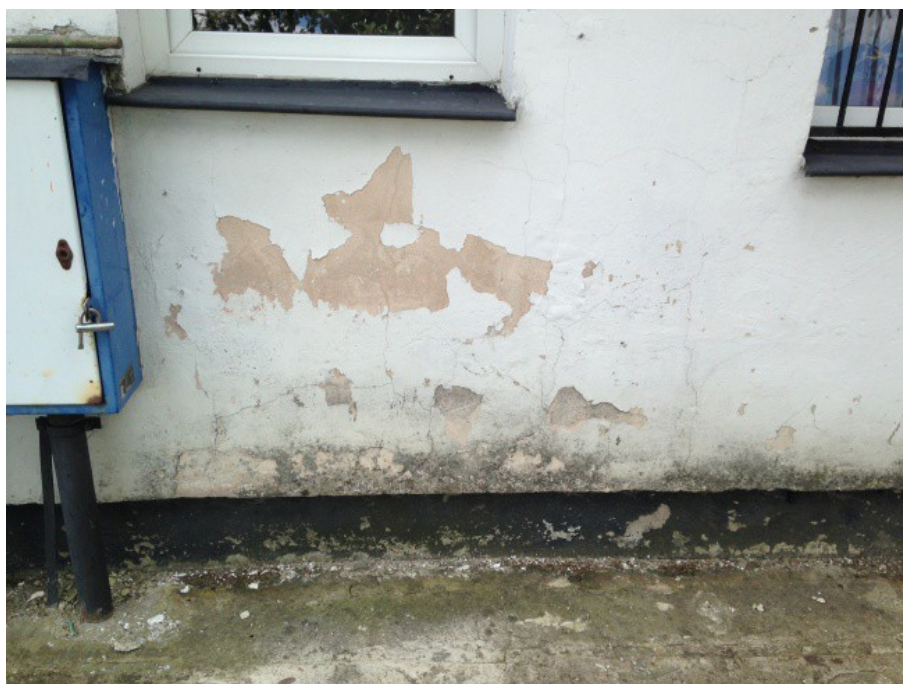
Fot.2 Uszkodzenia tynków zewnętrznych
