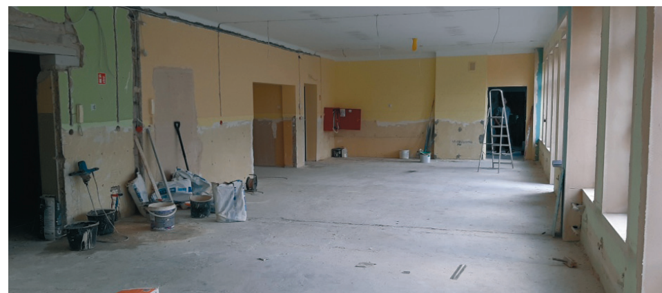
Remont potrwa do końca sierpnia
