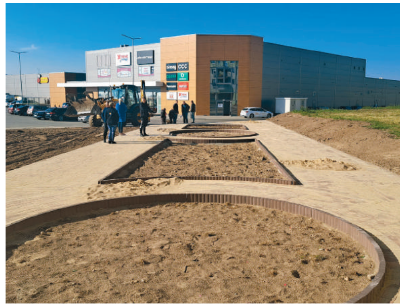
Przy Stacji Mława zakończyły się prace brukarskie
