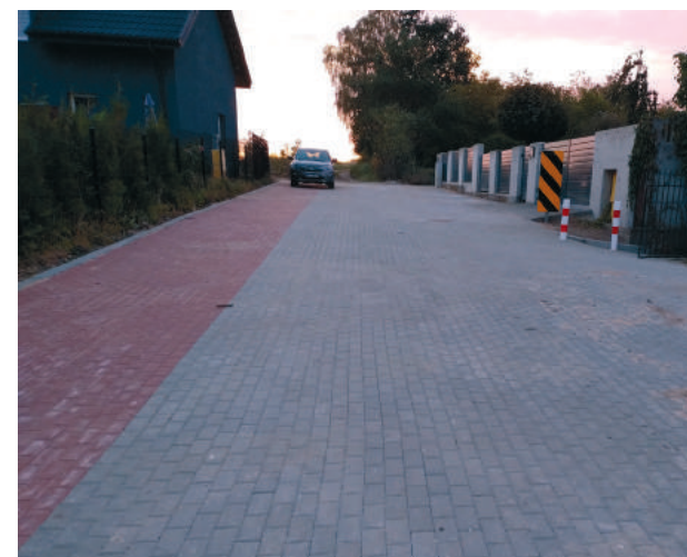
Ulica Piaskowa była remontowana w dwóch etapach
