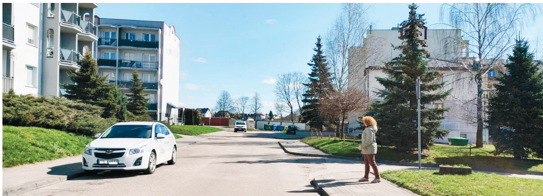
Na ul. Zacisze zaplanowano montaż pięciu lamp
