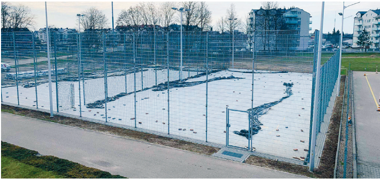
Budowa kortów tenisowych jest na ukończeniu
