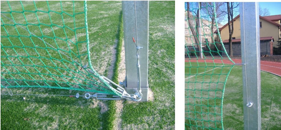
mocowanie siatki i odciągów
